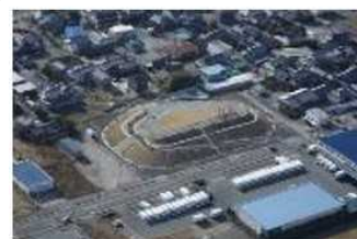
商業施設跡地等を活用した津波時の一時避難場所の整備（静岡県袋井市）事例㉑
