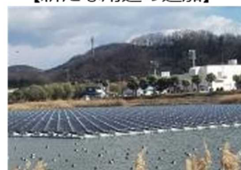
遊水池・ため池を活用し環境に配慮した水上太陽光発電（岡山県笠岡市）事例② （自然エネルギー財団HPより）
