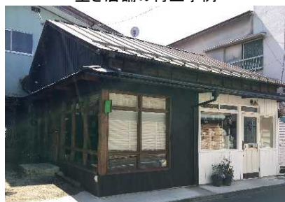
空き店舗の再生事例
