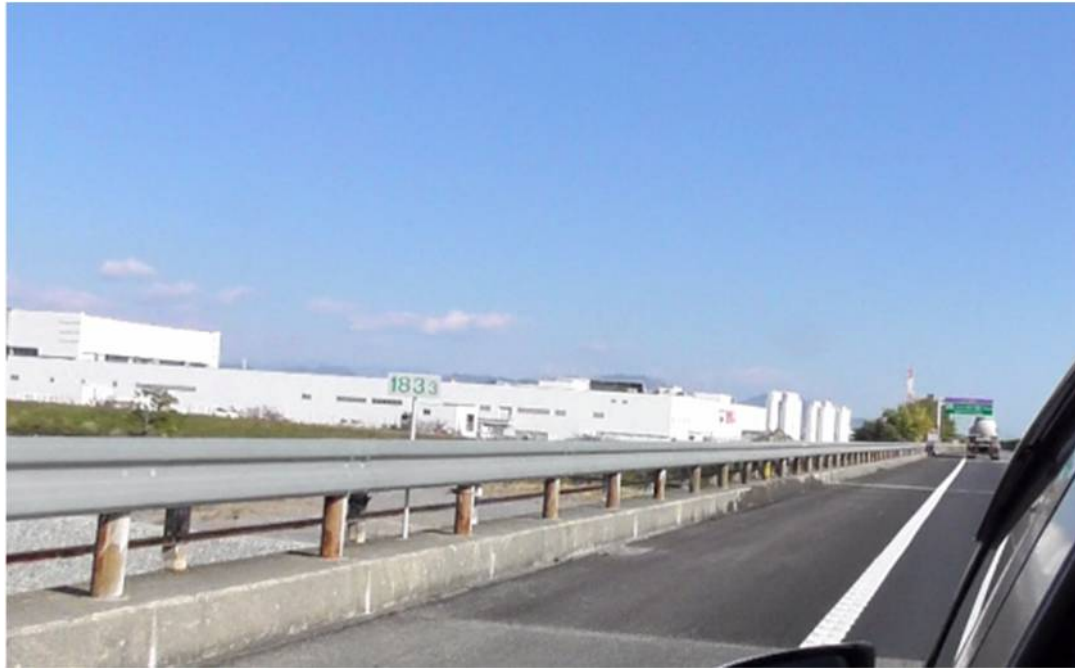
写真 6 - 1 事故地点付近（橋上の直線道路）
