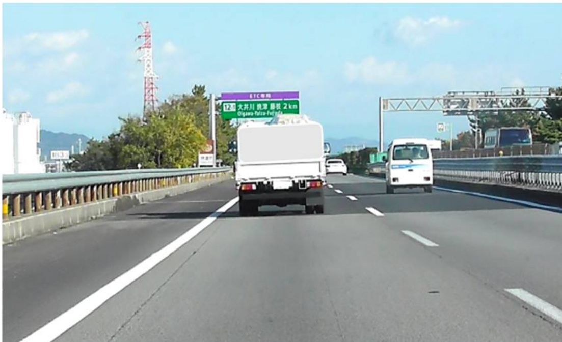
写真 6 - 2 事故地点付近（橋上の直線道路）
