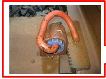
レール位置を調整可能な締結装置
