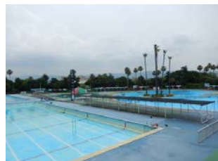
東側緑地_プール内からの景観
