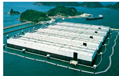
図 3.9.6 (b) 上五島石油備蓄基地の海上タンク
