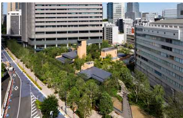
「赤坂・虎ノ門緑道構想」の起点であり具体化である 200 m の並木道に沿ってせせらぎや店舗を配置した。
