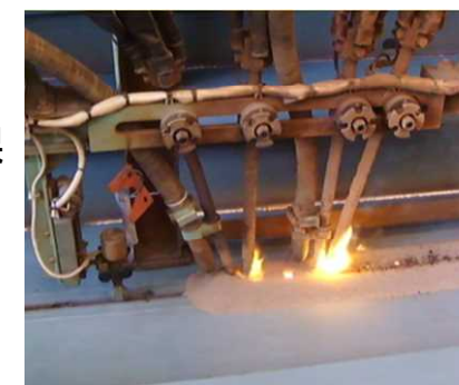
片面サブマージアーク溶接法
