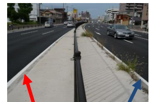
防草ブロックを使用 従来ブロックを使用
