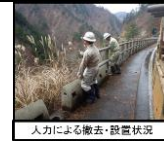
人力による撤去・設置状況
