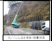
クレーンによる荷立・設置状況
