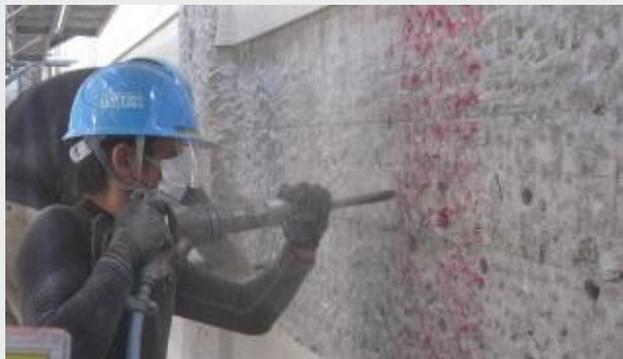
さらに、既往の研究によると、既存躯体に加える打撃振動により、コンクリート表面に**微小なクラック**が生じて、既存躯体と補強体の一体性を阻害させる要因となることが指摘されている。
