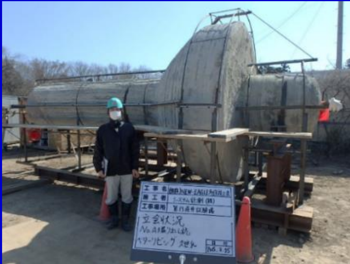
掘出し杭(先端拡底 傾斜角 45^\circ )
