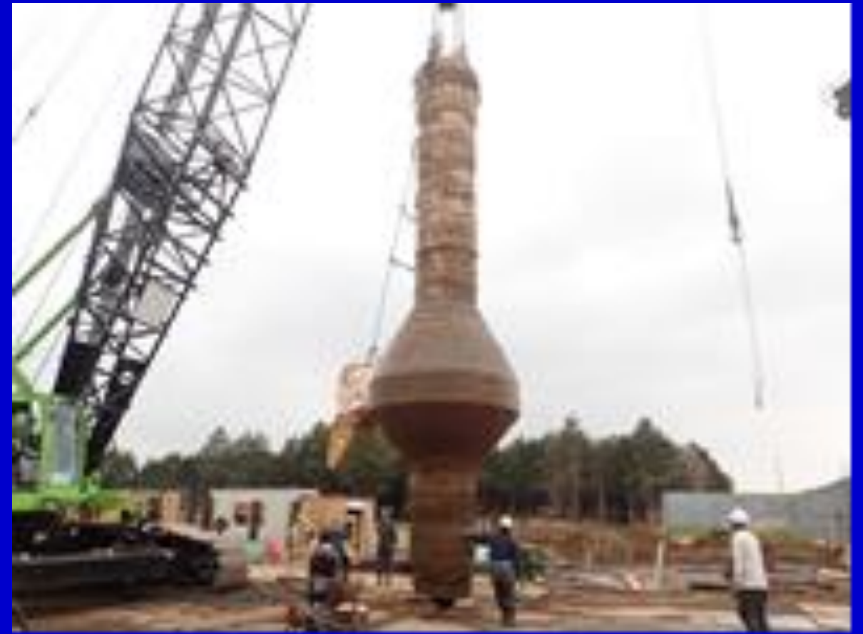
掘出し杭(中間拡径 上部傾斜角 30^\circ )
