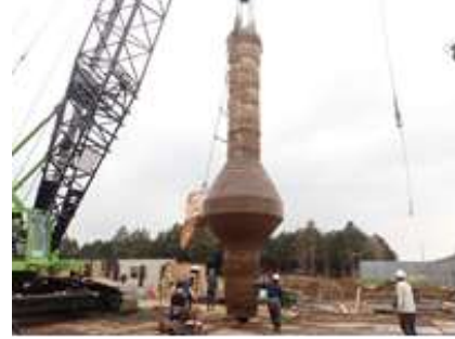
掘出し杭(中間拡径 上部傾斜角 30^\circ )
