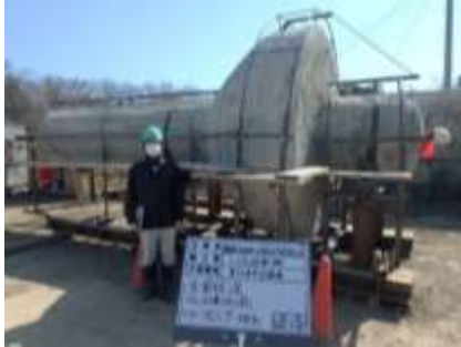
掘出し杭(先端拡底 傾斜角 45^\circ )
