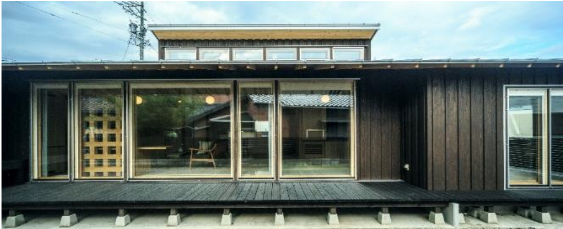
南面に7.2m+1.8mの大開口(木製クワトロサッシ)をもつエコモデルハウス
