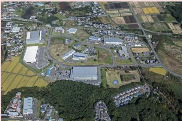
市街化区域の拡大により形成された盛岡西リサーチパーク (市ホームページ)
