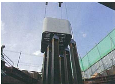
橋梁下部工 橋脚部の埋設型枠
