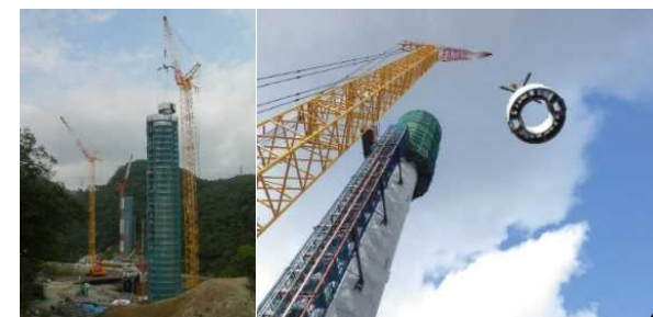
クレーンで吊り込み設置
