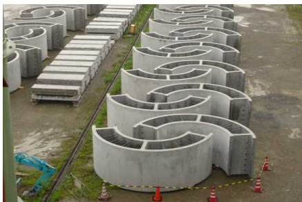
工場から現地に搬入
