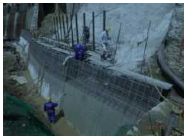
擁壁工 外壁の埋設型枠
