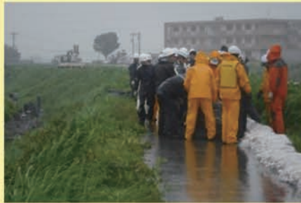
石川県小松市消防団 積み土のう工を実施 (8月8日台風第5号:梯川右岸)
