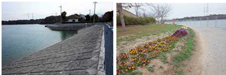
改修した副堤防（平成30年3月撮影）
