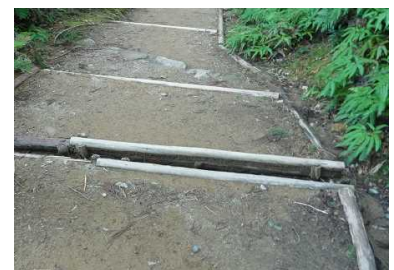
間伐材の古道排水溝への有効利用
