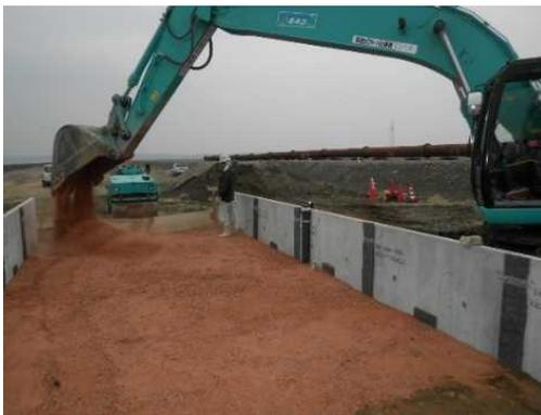
破碎瓦の埋立材としての適用性を現地試験により確認
