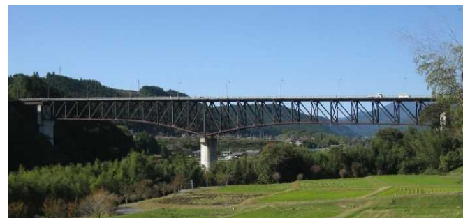
<乙姫大橋の状況>
