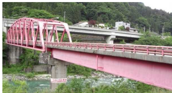
<音沢橋の状況>
