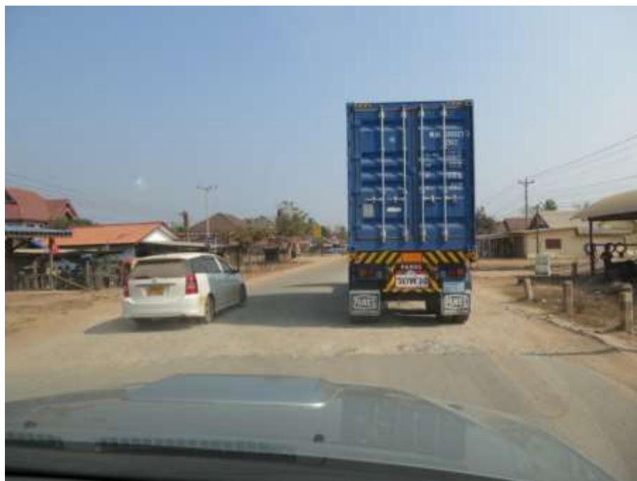
図 ラオス国内の舗装工事中の道路（9号線）
