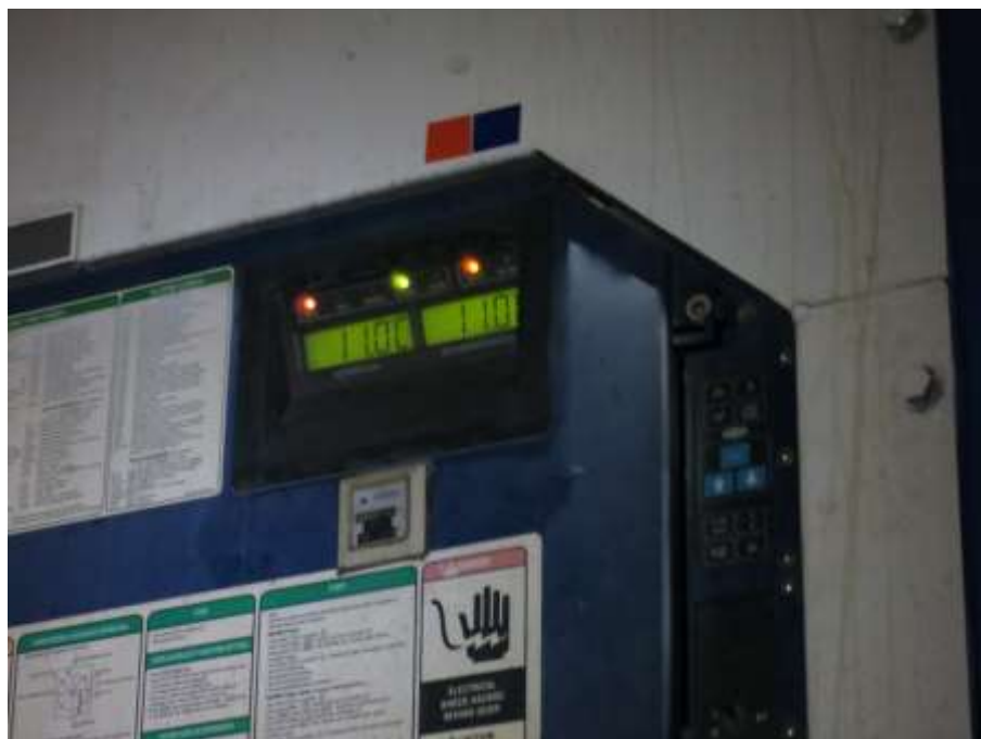
図 リーファーコンテナの輸送終了時の温度 (左数字：設定温度、右数字：コンテナ内温度)
