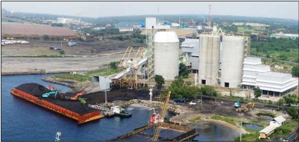
図 1-24 RORO 船利用可能とされるバンテン港のバース No.6
