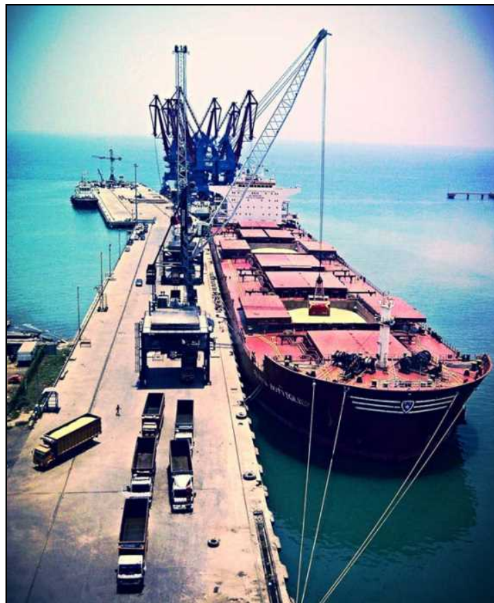
図 1-25 RORO 船が着岸可能とみられるバース No.5
