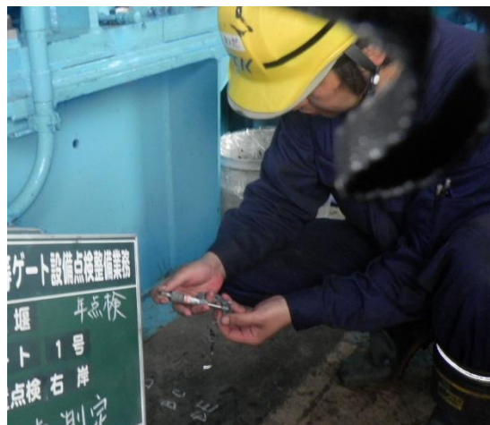
図3 ギヤのバックラッシの計測方法
