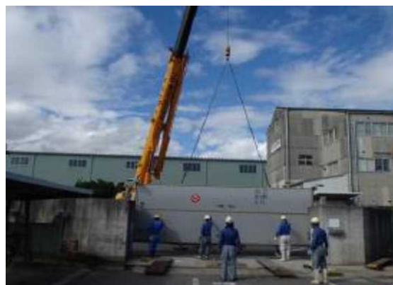
写真 2.2.6 防潮堤、防潮壁の設置事例
