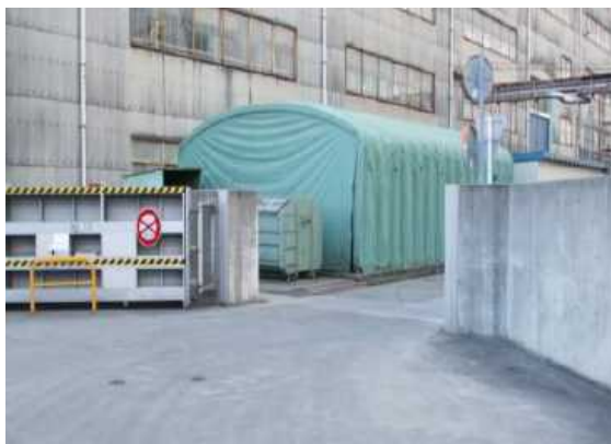
写真 2.2.6 防潮堤、防潮壁の設置事例
