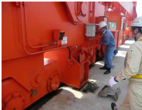
写真 2.2.3 転倒防止アンカー設置事例
