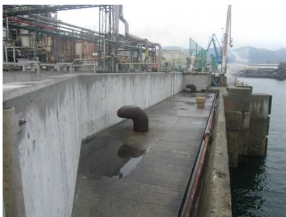
写真 2.2.7 岸壁水際部分の嵩上げ
