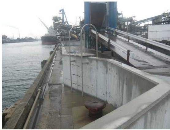
写真 2.2.7 岸壁水際部分の嵩上げ
