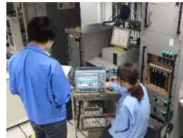
（航空保安施設点検実施状況）
