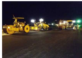
（老朽化した滑走路舗装の改良）
