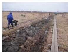
水抜き水路の埋め戻し
