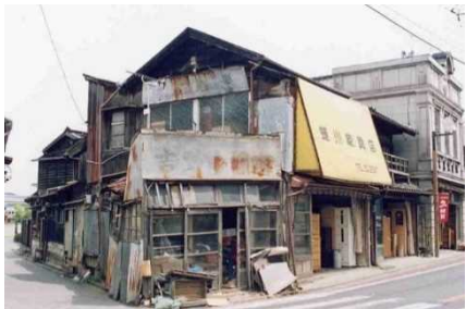
家具屋の改修
