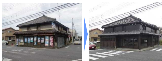
傷みが進んだ上屋の瓦のスレ直し、2階壁面並びに軒裏の剥離した漆喰の修繕
