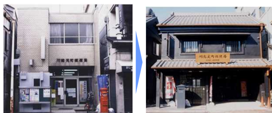
周囲のまちなみと調和するよう、前面を蔵造り外観に修景。
