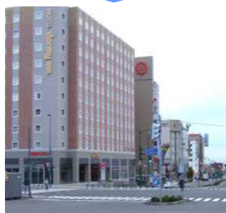
広告塔の撤去
