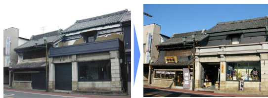
蔵造りの建造物の鋼板によるファサードをかつての外観に復元、壁面を黒漆喰により修繕。
