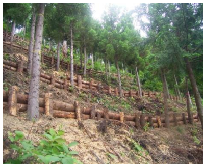
間伐材を活用した山腹保全工
