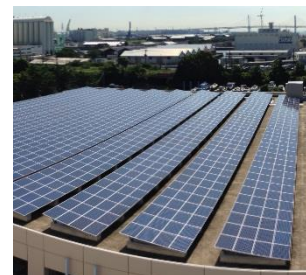
神奈川水再生センター (横浜市・約900kW規模)
