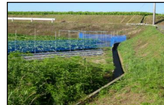
農地侵食防止のための農地保全水路
