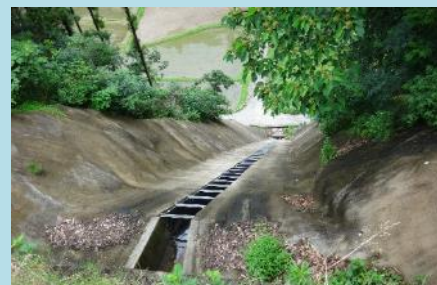
法面排水対策(斜面侵食防止)
