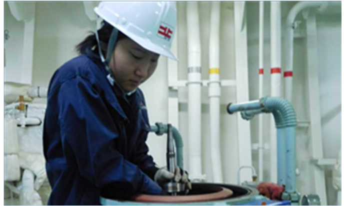
油清浄機の定期整備中の田中三等機関士 「やりがいは主機や発電機など様々な役割の機械に触れるところです。構造や整備方法など覚えることがたくさんあり大変ですが、原理や構造がわかって面白いです。」
