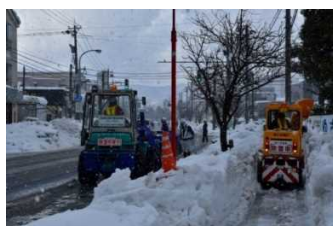
歩道除雪（福井市）
