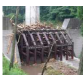
透過型砂防堰堤による流木捕捉事例
