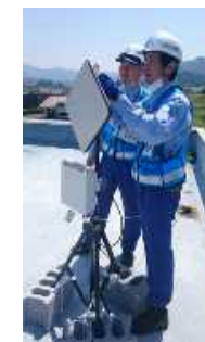
可搬型の高速データ通信設備
