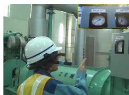
ウェアラブルカメラを用いた機器異常確認
