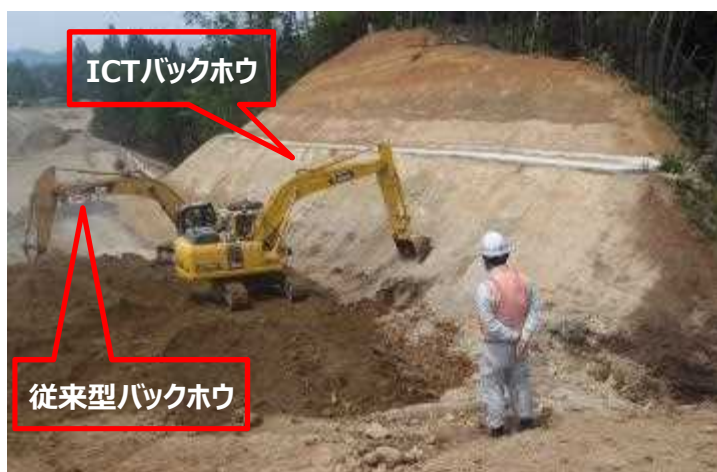
ICTと従来型の建機による施工
