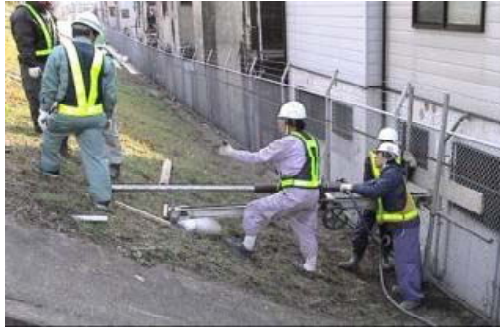
地下水排除工の例
