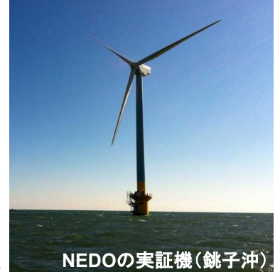
【洋上風力発電設備のイメージ】
