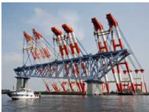
施工時の安全確保事例
