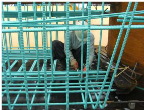
耐久性向上のためエポキシ樹脂塗装鉄筋を適用
