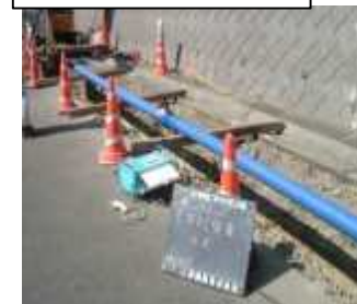
配水管の新設
