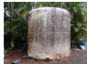
昭和47年に設置された経年劣化や漏水が発生しているFRP水槽
