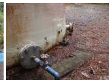
昭和47年に設置された経年劣化や漏水が発生しているFRP水槽
