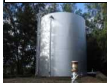
清瀬配水池の建替
