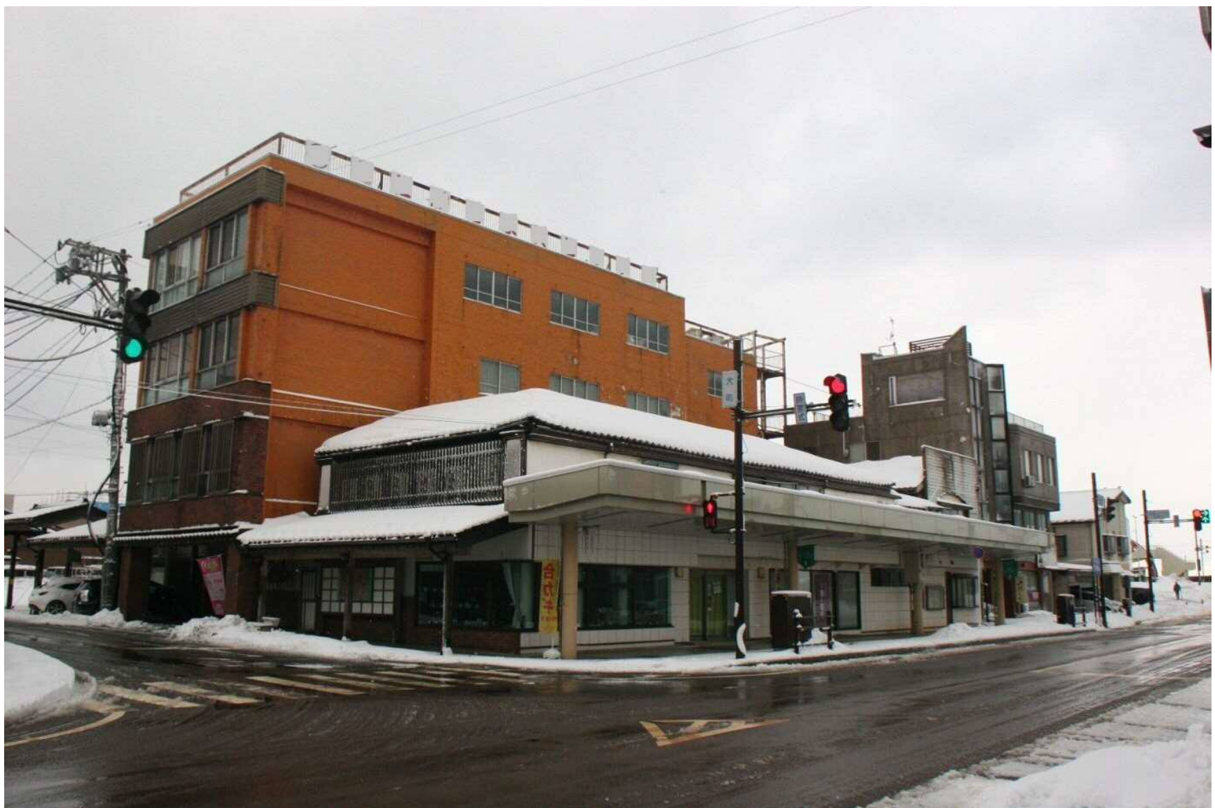
写真①駅前通り・本町通り交差付近（2018. 1. 30 撮影）
