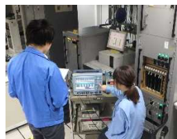
(航空保安施設点検実施状況)
