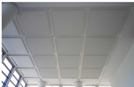
【天井耐震対策の例（熊本地方合同庁舎玄関ホール）】
