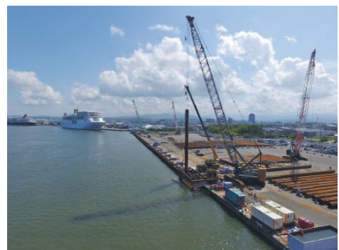
金沢港無量寺岸壁の工事状況
