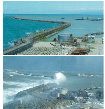
夏は穏やかだが(写真上)、冬は北西の季節風が長時間吹き続け、時には7mを超える激しい高波が観測される
