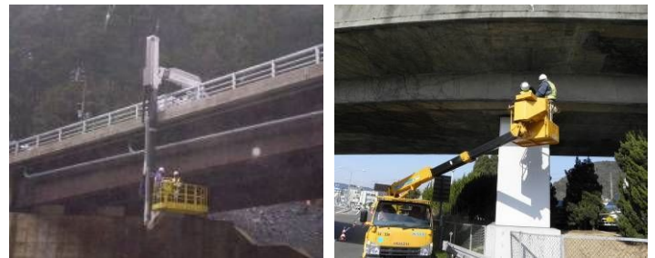
図 4.1 定期点検の様子
