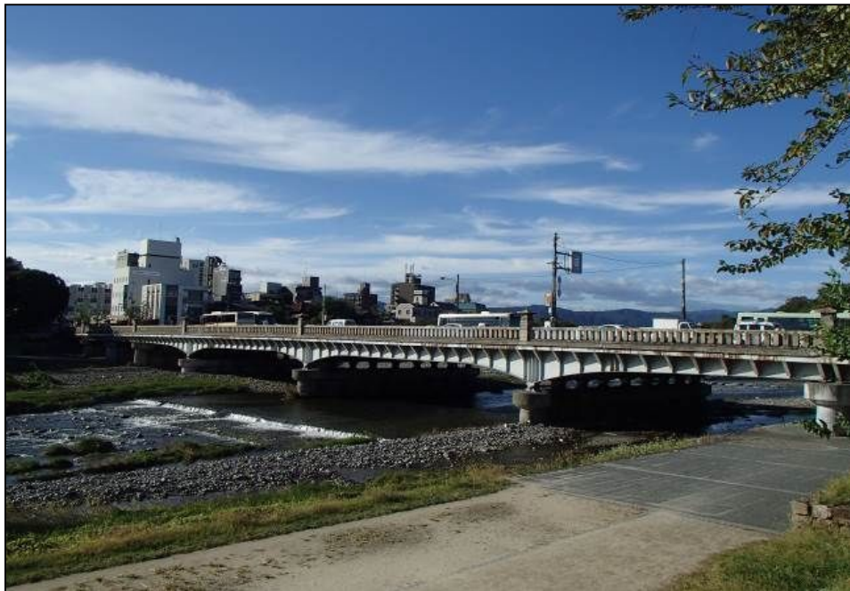
写真：賀茂大橋（昭和6年完成）
