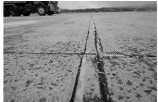
写真-6 目地補修跡
