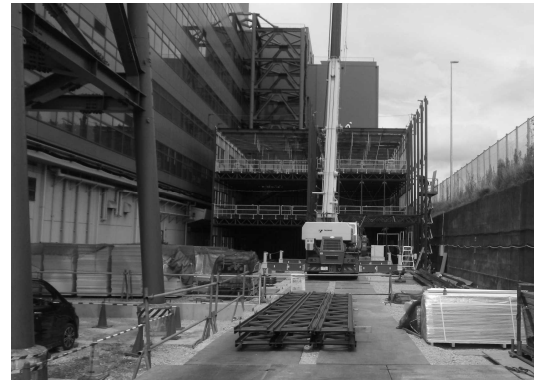
図 6. 北側からの建て逃げの様子
