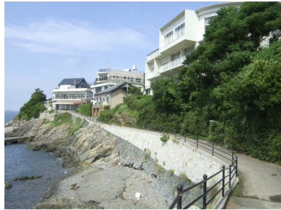
②⑤遊歩道 遊歩道は、福浦海岸や大塚海岸ともつながっている。赤穂コールドロン（カルデラ）の地層を見ることができる箇所がある。
