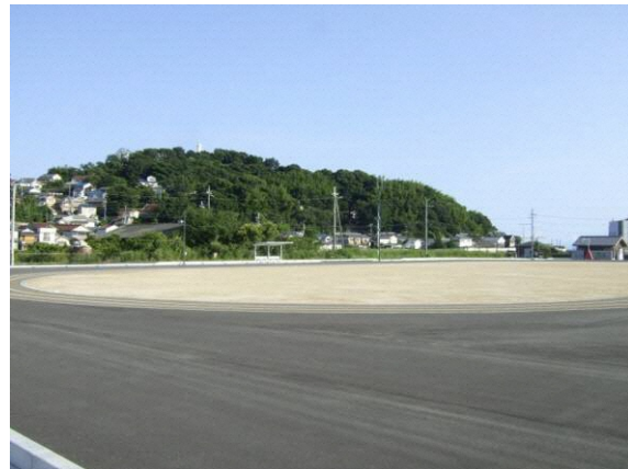
⑨みなとひろば 真砂土グラウンドが整備され、その周辺はアスファルト舗装で囲まれており、健康遊具、トイレ、駐車場がある。山の頂上に赤穂御崎灯台が見える。
