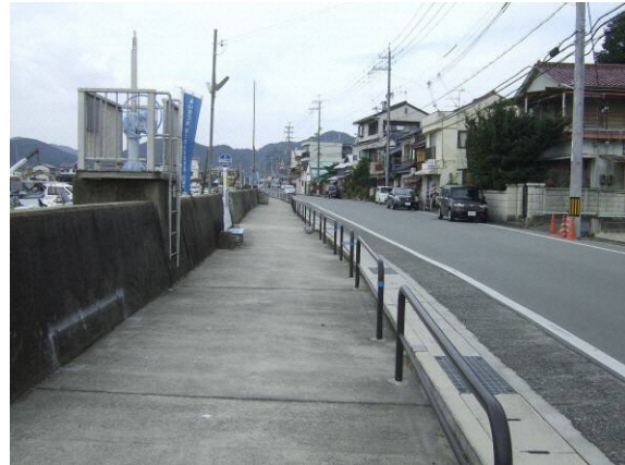
⑬海岸堤防 一部、管理用通路がある箇所では、歩行可能な空間となっている。
