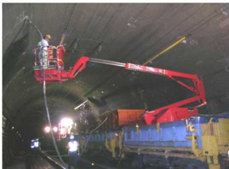
東海道新幹線土木構造物の大規模改修による長寿命化
