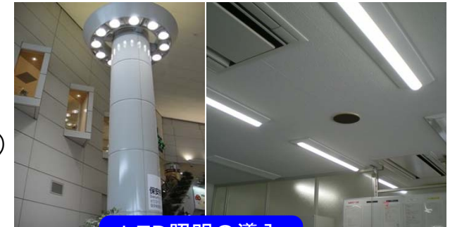
LED照明の導入
