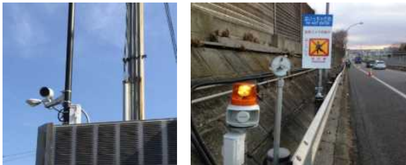
赤外線カメラ(左写真)で検知すると警告灯(右写真)で警告
