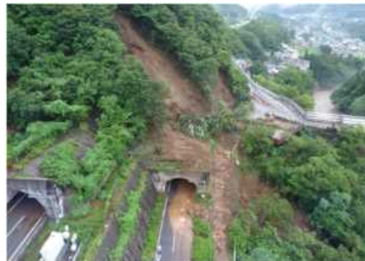
＜土砂崩落＞ 中央自動車道 (平成29年8月)
