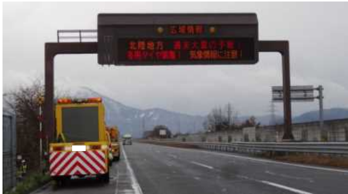
北陸自動車道 上り線 武生IC～鯖江IC間
