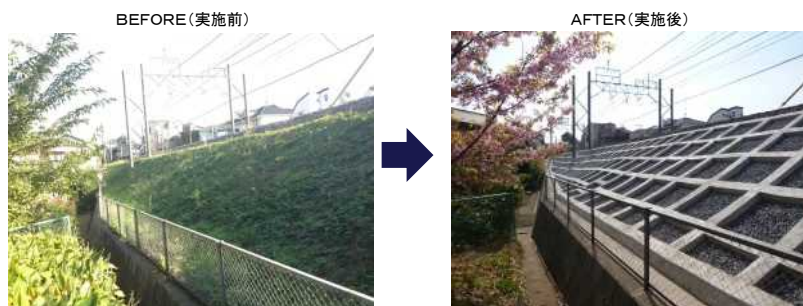
法面改修(施工例)
