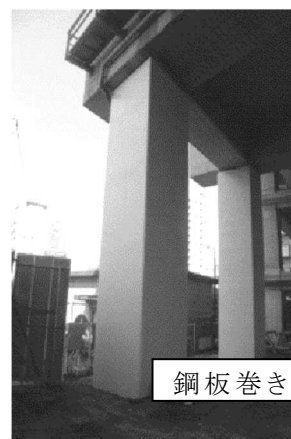
【高架橋の補強】
