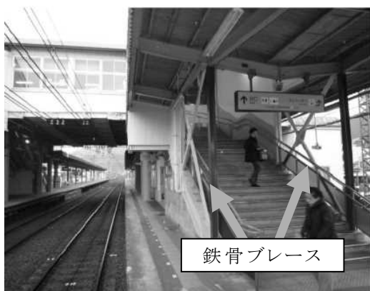
【橋上駅の補強】
