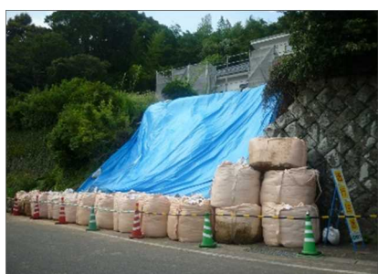
避難路を保全する土留工・排水工
