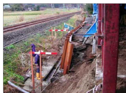
鉄道を保全する土留工
